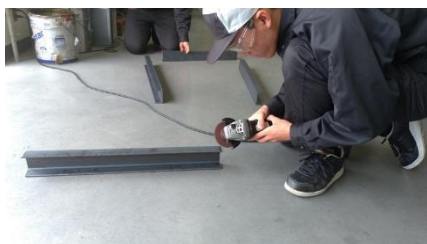
図 13 鋼材の切り出し
