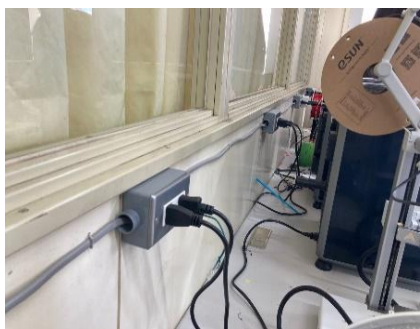
図 8 コンセント配線工事
