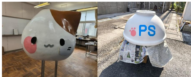
図 2-4 外装塗装の様子
