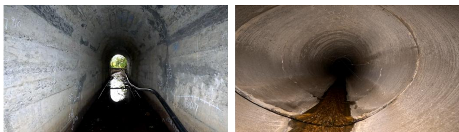
図1. 狭小な水路トンネル・水路管
