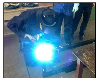
図4 フレーム溶接
